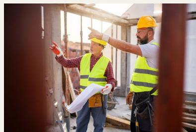
Einbau von genormten Baufertigteilen 48.000
